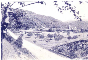
La costruzione della strada, oggi denominata Via Circ. Vigne, risale all'estate del 1940, quando fu costruito il "Ponte nuovo" e tagliata la Riva: la foto è stata scattata dal cavalcavia che conduce alla frazione Combe.
